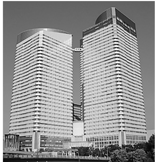
▲日本トラスティ・サービス信託銀行の入るビル
