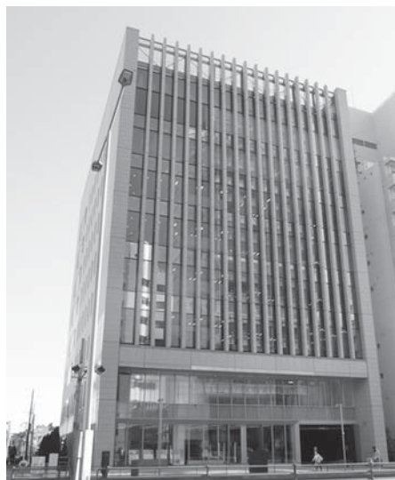
▲表参道に 2017 年に新築された本店ビル
